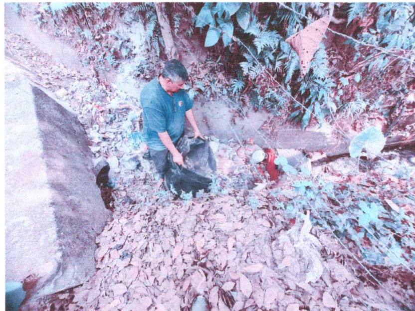
LIMPIEZA DE DRENAJE SALIDA DEL PUEBLO POR LA TOMA.
